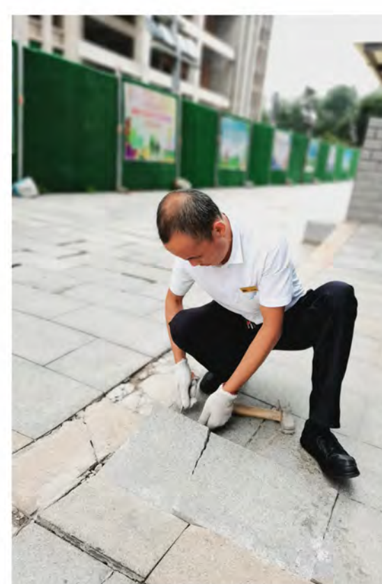
《修复每一处裂缝，哪怕只是一块砖》 摄影：闫晓（荣鑫物业-航空科技大厦）
